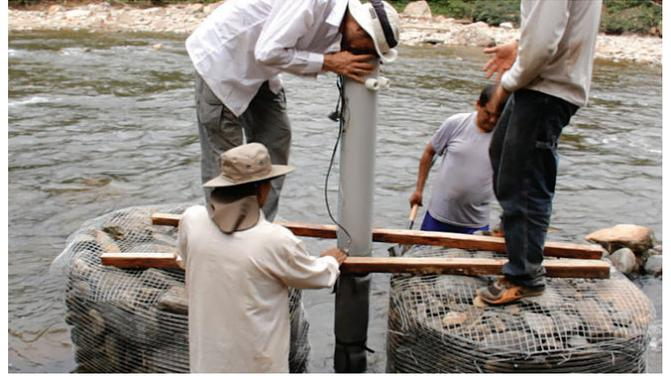
Colocación de la tubería de agua desde la bomba al tanque
