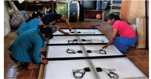
Montaje del sistema de 10 módulos de 75W en el techo e instalación de las caja de combinación.
