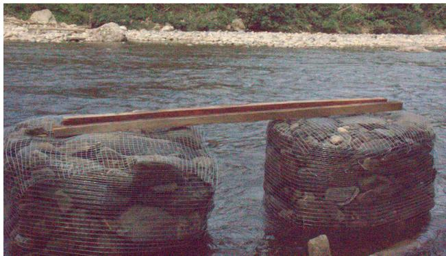
Construcción de dos gaviones a un metro de la superficie utilizando piedras y una malla de alambre. Los gaviones sirven de protección de la casa de la bomba.
