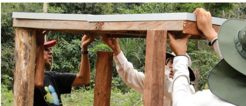
Montaje del SFV de los dos módulos conectados en serie con una estructura de madera.
