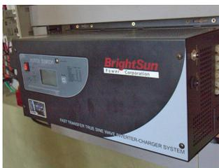
Los SFV generan energía de corriente directa y las baterías solo pueden almacenar la energía en forma de corriente directa. La mayoría de los aparatos y cargas operan con corriente alterna. Por su naturaleza, la CD no es compatible con la CA, por lo que se hace necesario un "puente" o inversor entre las dos.
